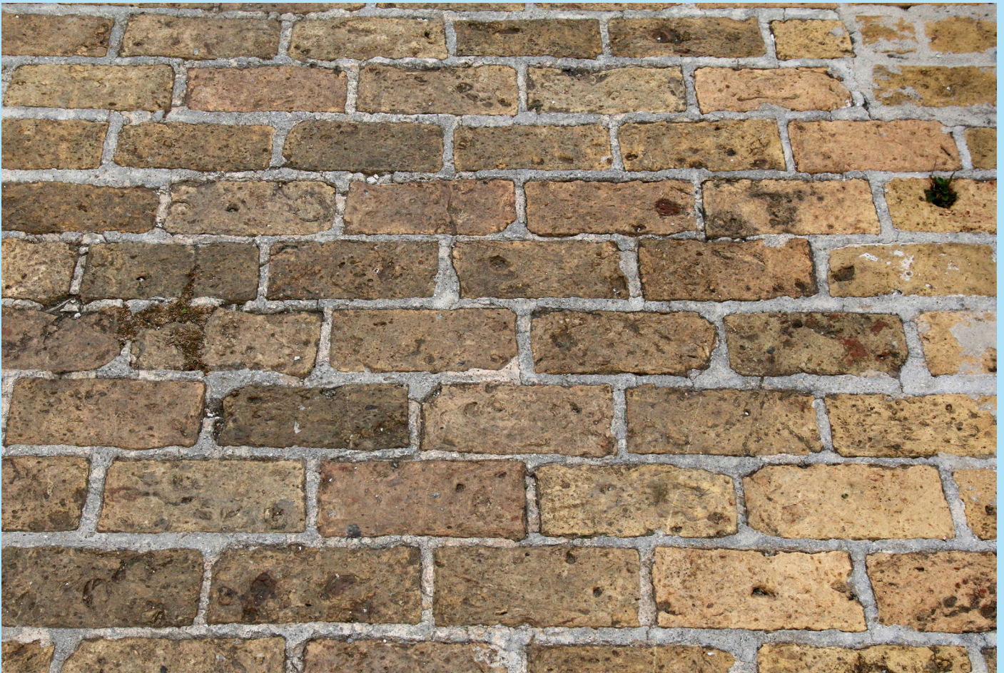
Pad van ijsselstenen, Fort Nassau. De iets grijzere stenen waren wat poreuzer en hebben wat stof en algen opgenomen
