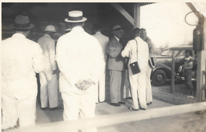
Binnenzijde "Stations gebouw" Subi Blancu
